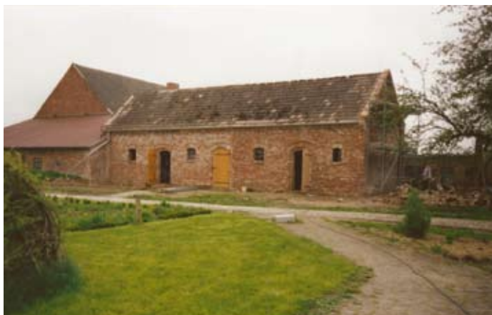
Ceres Jätneshof e.V. Ortwig, im Außenbau (Arbeits- u. Vorratsräume)
